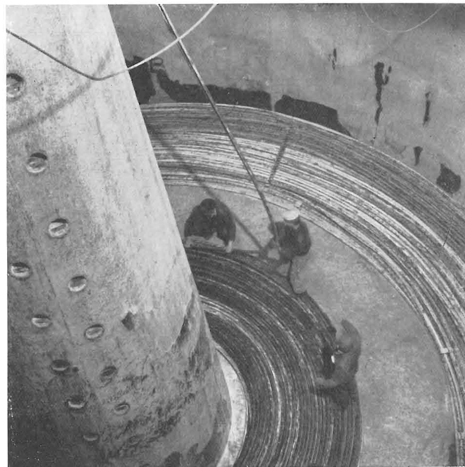
La Reale Nave Monarch, che è la più grande nave posa-cavi del mondo, colloca il primo cavo telefonico transatlantico, secondo il progetto congiunto della Gran Bretagna, del Canada e degli Stati Uniti. In questa fotografia il cavo viene caricato a bordo della Monarch.
